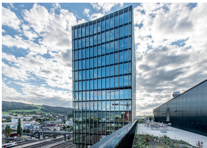
Abbildung 19: Hochhaus Arbo, Rotkreuz
