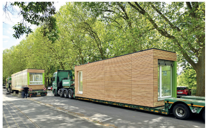
Abbildung 10: Raummodule aus Holz auf dem Tieflader
