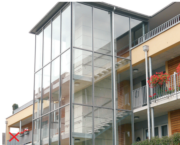
Figura 17: Questa scala offre grande visibilità ma è pericolosa per gli uccelli. In primo luogo occorrerebbe apporre delle decorazioni agli elementi laterali. © Archivio Stazione ornitologica svizzera
