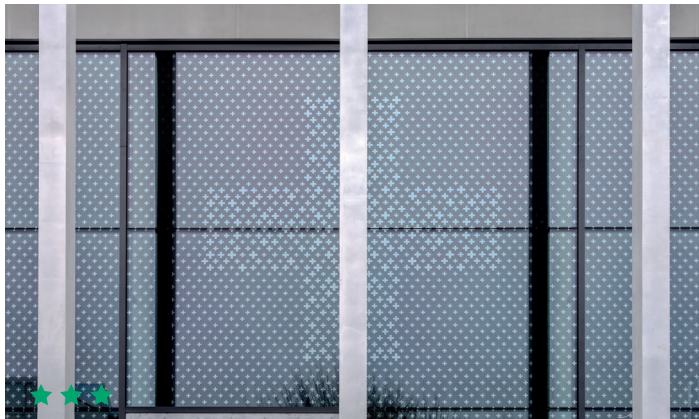
Figura 8: un'altra prassi esemplare è quella della Waffenplatz di Frauenfeld: la facciata in vetro della mensa è stata decorata con un motivo che impedisce le collisioni con gli uccelli. © René Dürr
