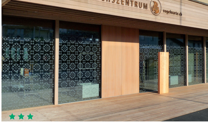
Figura 7: le vetrate del centro per visitatori della Stazione ornitologica svizzera sono state decorate con un mandala formato da uccelli (stampa digitale). © Archivio Stazione ornitologica svizzera
