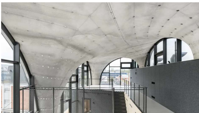
Selbsttragendes HiLo-Deckensystem, ETH Forschungsgruppe Block Research Group
