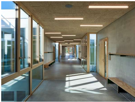
Beton mit RC-Gesteinskörnungen im Schulhaus Gebenstorf
