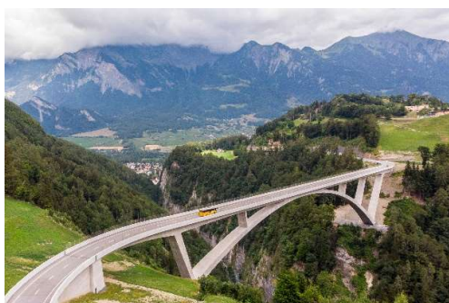
Taminabrücke, St. Galler Tagblatt.ch
