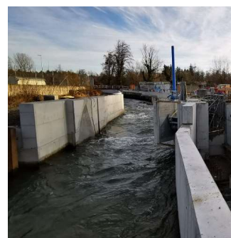
Tragfester Beton aus EOS-Granulat vom Stahlrecycling für den Ausbau der erneuerbaren Energieproduktion mit Wasserkraft
